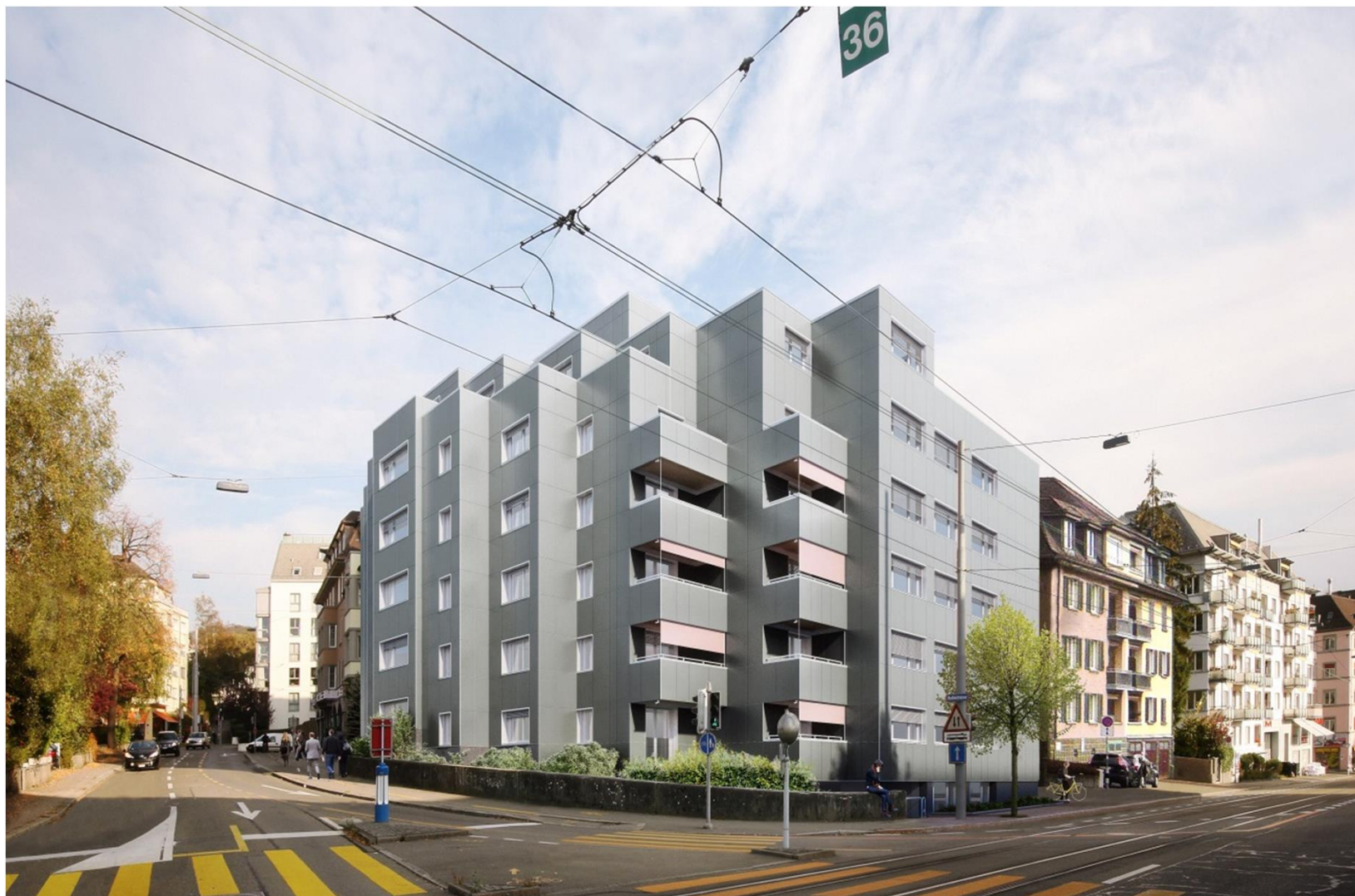
Appartementencomplex Renovatie 180 kWp
